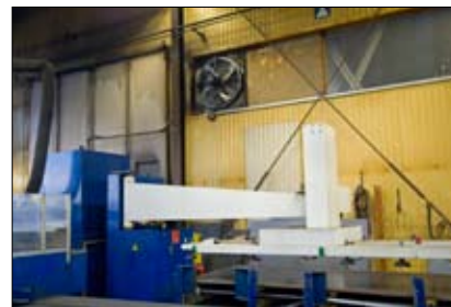
Näst på tur att åka ut är fläkten som ventilerar bort värme från fabrikslokalen. Hakfelts ska satsa på värmeåtervinning.
